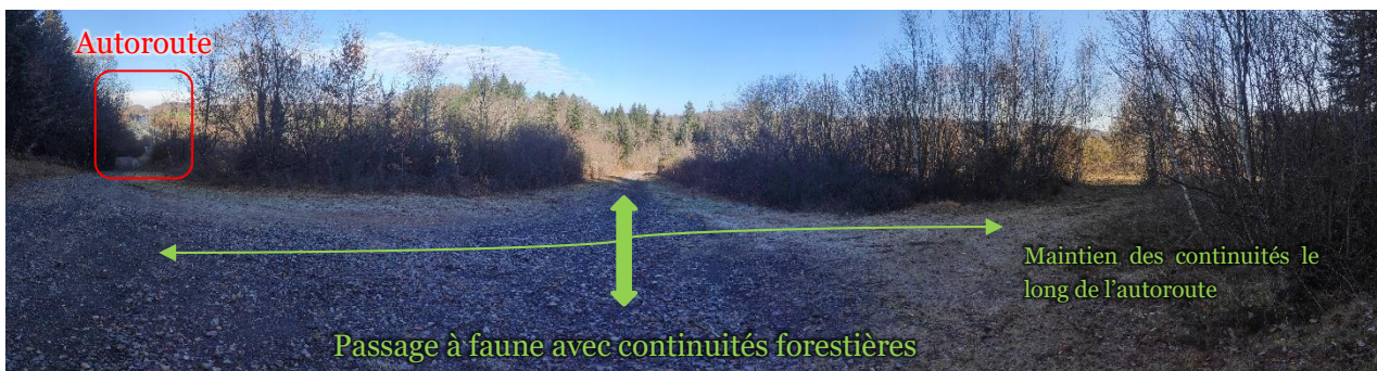
Photographie 28 : Vue panoramique du passage à faune sur la commune de Naves (© T. ROIG)
