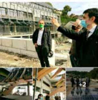
Architecte et chef de chantier ont fait visiter à des élus de Tulle Agglo, vendredi dernier, les locaux en travaux, qui accueillent aussi la bibliothèque du Campus universitaire Le Néa. Affichez la suite
