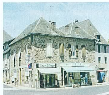
Ensemble de bâti à Lagraulière
